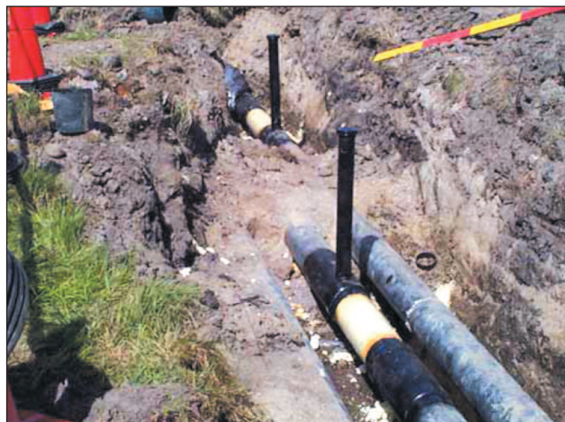
Рис. 3. Внешний вид экспериментальных участков труб в ППУ изоляции без внешней полиэтиленовой оболочки.
